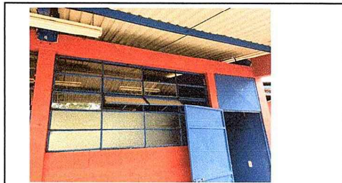
Foto 4: Sustitucion de Puerta en mal estado
